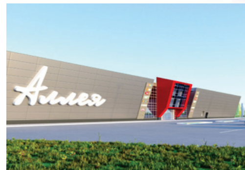
г. Южно-Сахалинск, ТРЦ Аллея Водосчетчики BOLID СВК-15-3-2-Б АРМ «Ресурс» 210 ПУ
